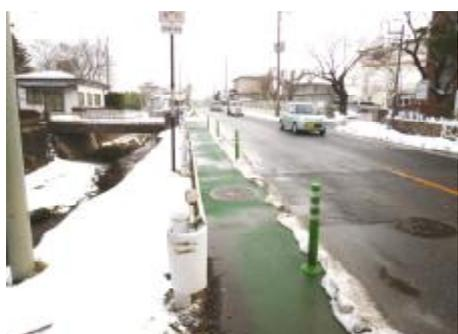
道幅が狭い上に交通量も多く危険な状況であったが、路側部のカラー舗装、ポストコーンの設置によって、運転者への注意喚起が図られ、児童も安心して歩行できるようになった。
