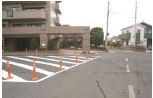
道幅が狭いにもかかわらず、非常に多くの児童生徒が利用する交通量の多い変形の交差点になっている危険箇所であったが、路側部のカラー舗装、ポストコーンの設置、ゼブラゾーンの設置等により、運転者への注意喚起と児童生徒の安全な歩行の確保が図られた。
