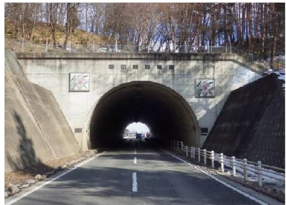
写-2.2 大槻トンネル
