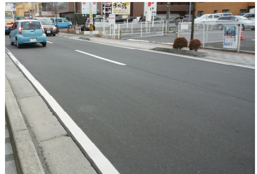
写-2.1 舗装現況(市街地)
