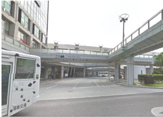
写-2.3 郡山駅ペデストリアンデッキ
