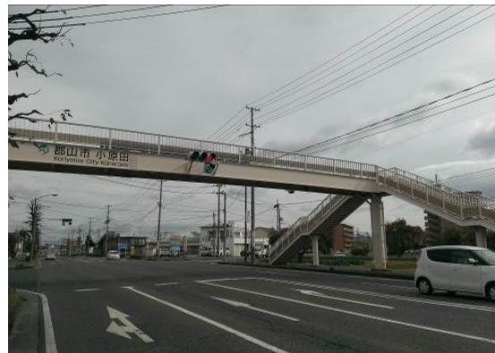
写-2.6 小原田歩道橋
