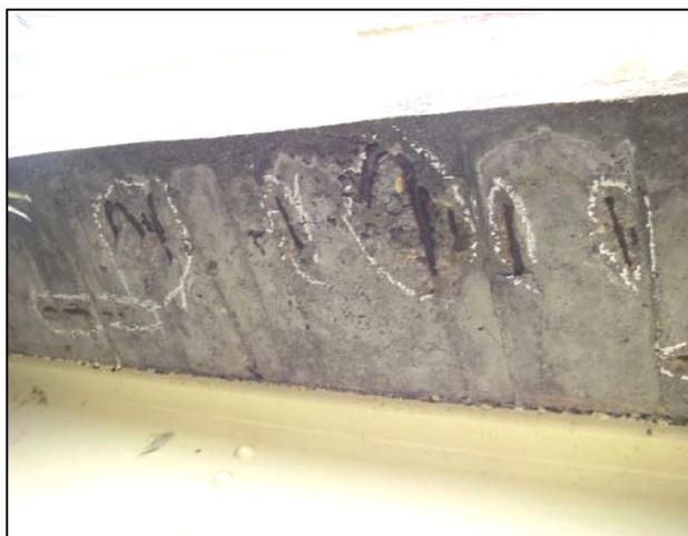
図 2.2.2 床版下面 はくり・鉄筋露出
