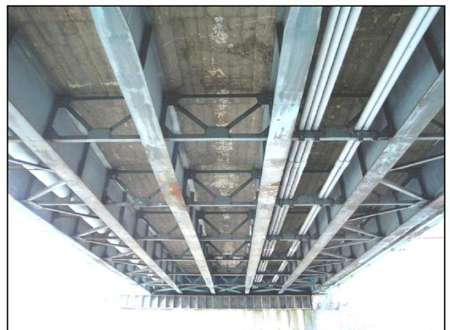
図 2.2.3 床版 漏水・遊離石灰
