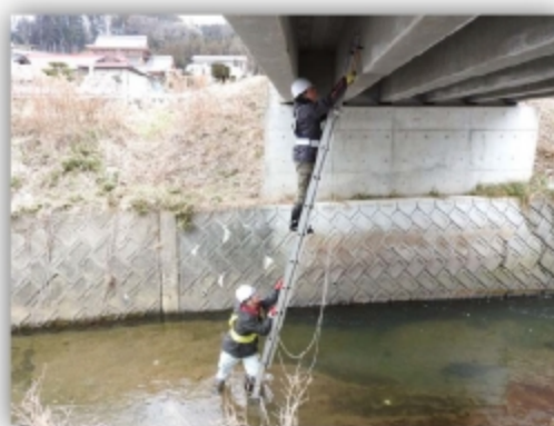
▲梯子を使用しての点検
