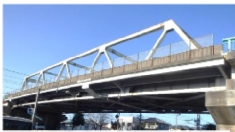
▲重点管理橋梁 JR 線路を跨ぐ橋 ・大黒橋 (橋長 153.0m、幅員 18.0m)
