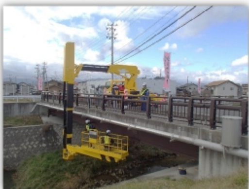
▲橋梁点検車での点検
