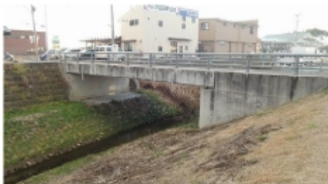
▲簡易予防保全橋梁 ・静橋 (橋長 14.2m、幅員 6.0m)
