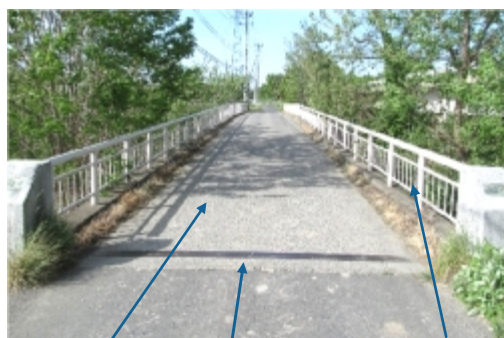
▲路面から見た橋梁
