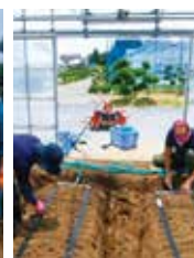
▲かん水チューブ 設置作業
