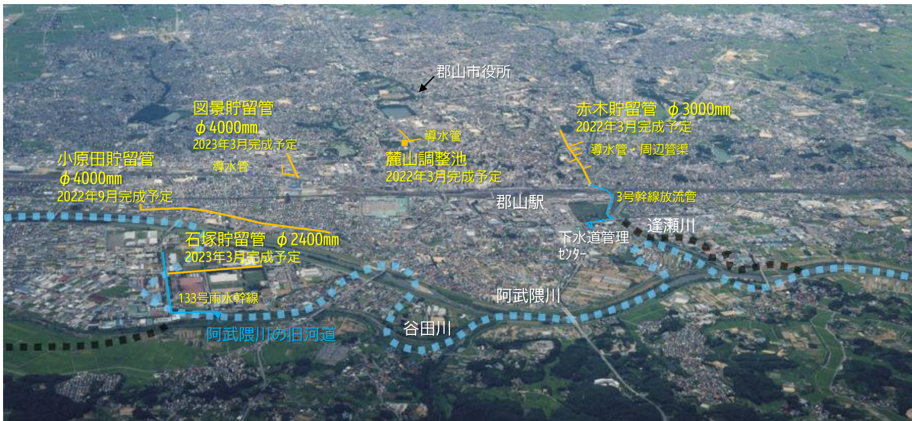
【雨水貯留管等の整備状況】
