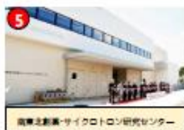
5 高専北郡第一サイクロトロン研究センター
