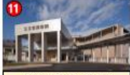
11 公立岩瀬病院(須賀川市) 二次救急、産産期医療協力施設
