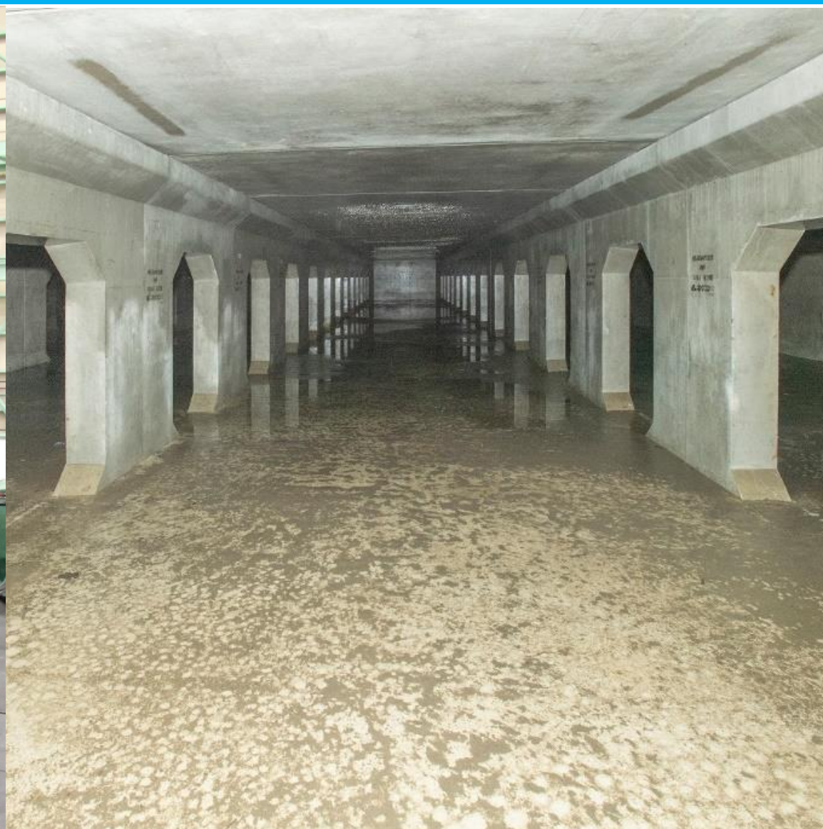
麓山調整池（2020年4月供用）（郡山市）
