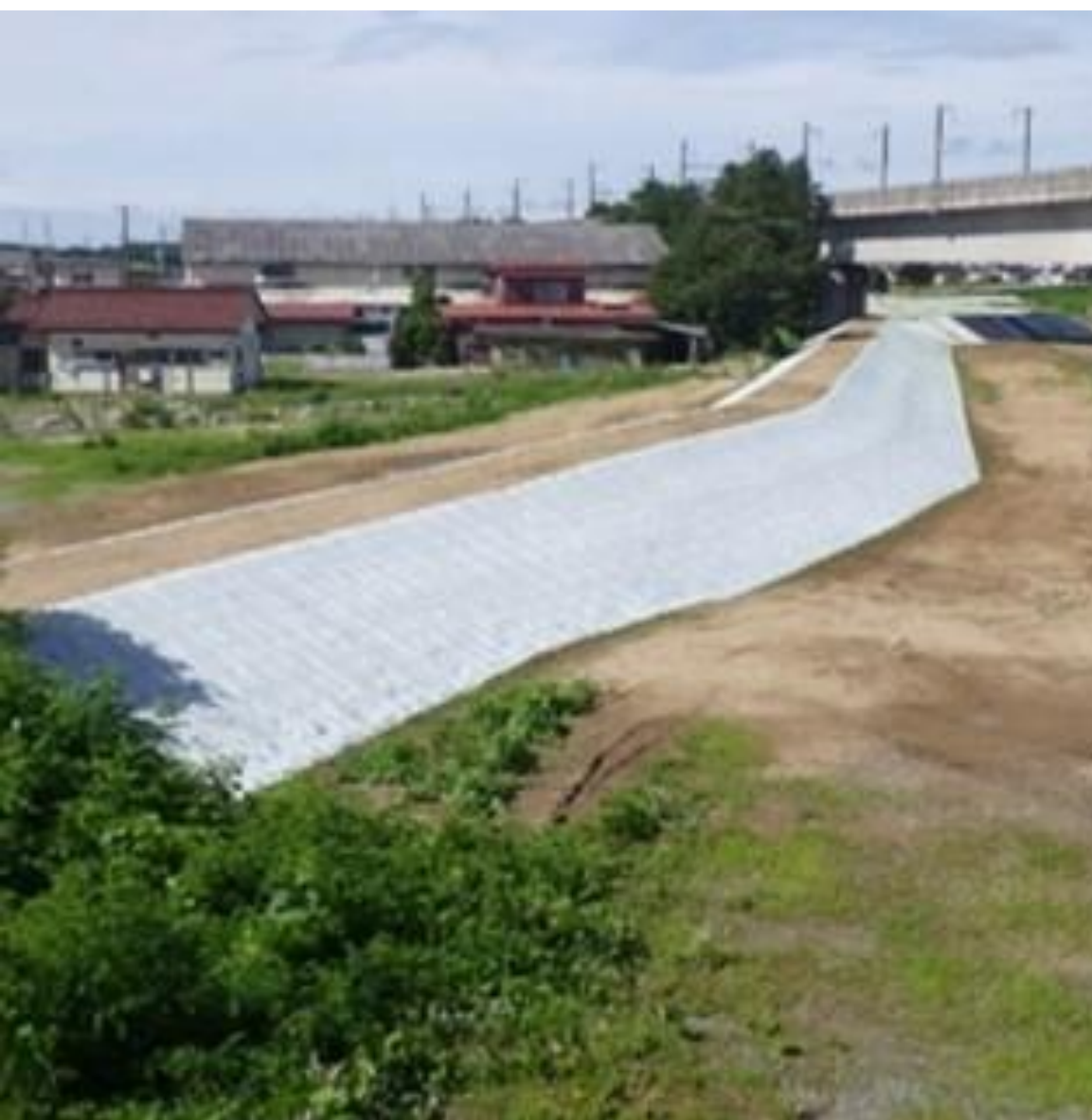
阿武隈川御代田地区堤防整備 (国土交通省)
