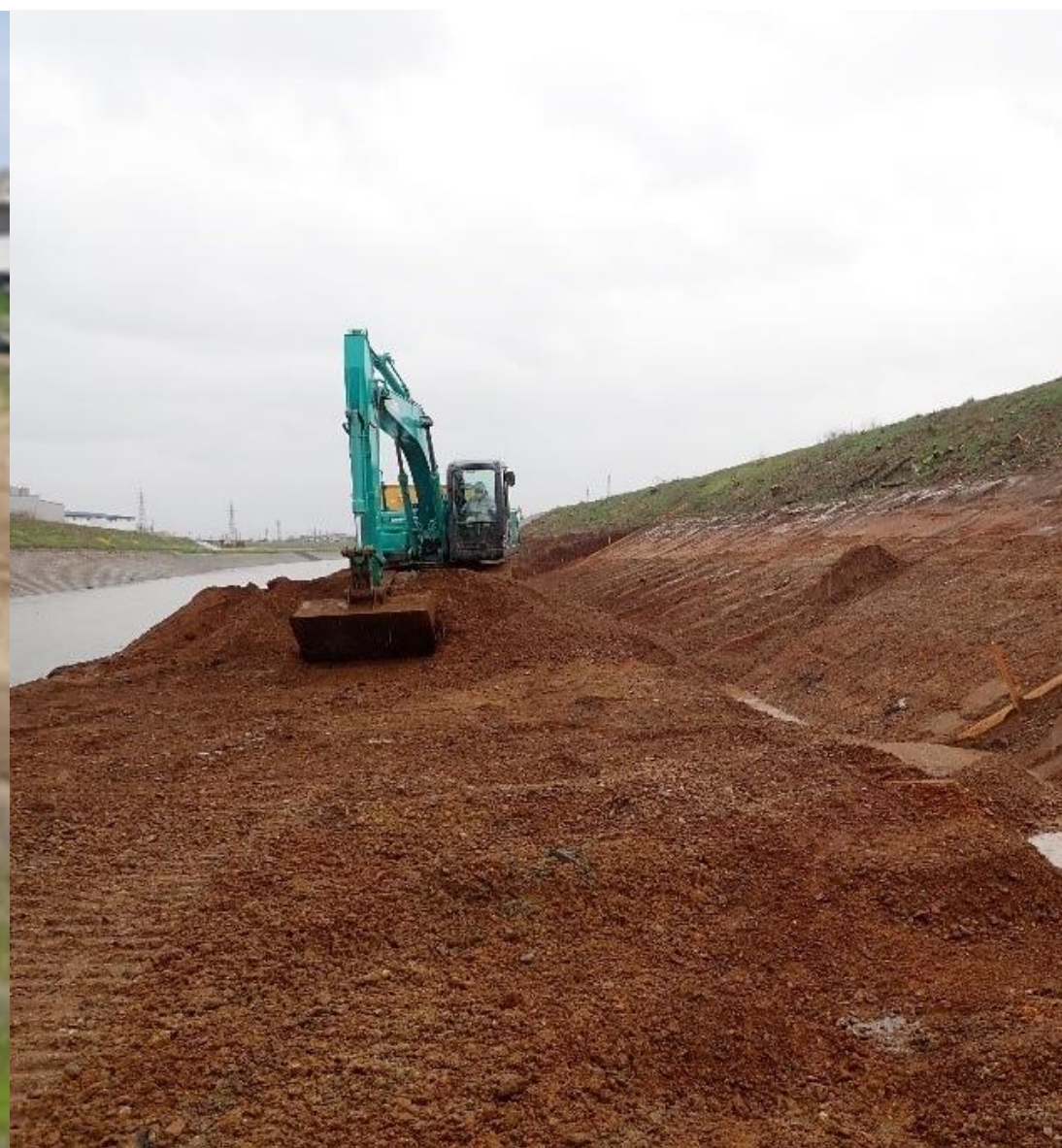
谷田川河道掘削工事 (福島県)
