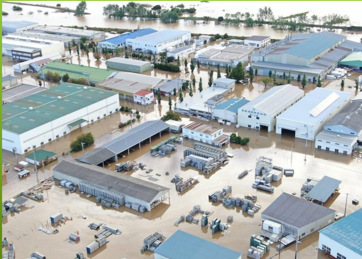
▲中央工業団地の浸水被害状況(写真提供：スペースワン)
