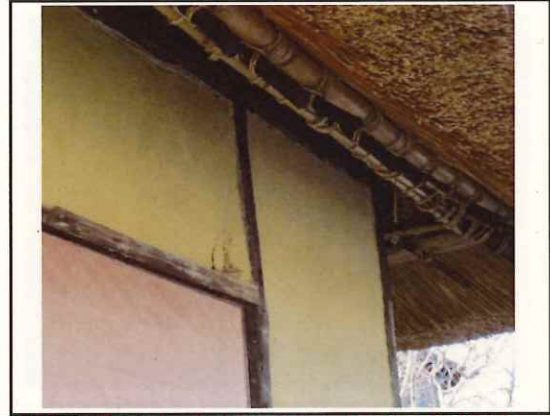
安積開拓入植者住宅(旧小山家) 壁修繕
