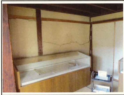
立岩邸 壁修繕
