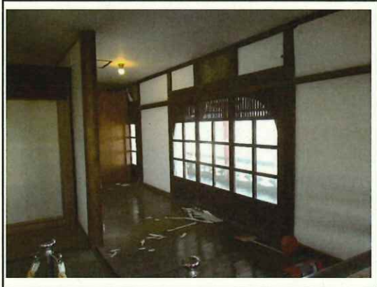
開成館 壁修繕
