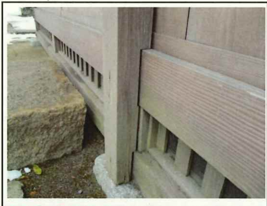
立岩邸 柱等修繕
