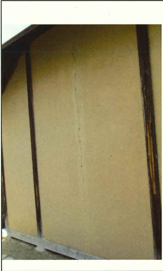
安積開拓入植者住宅(旧坪内家) 壁修繕
