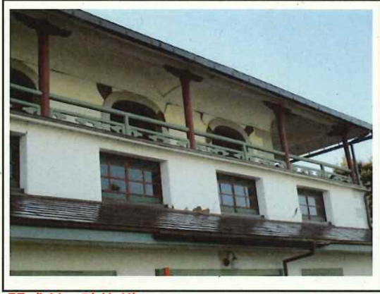
開成館 壁修繕
