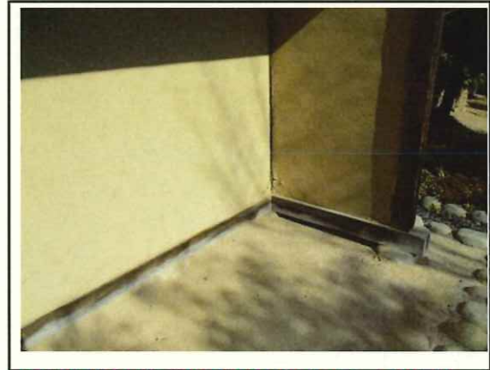
安積開拓入植者住宅(旧坪内家) 壁修繕
