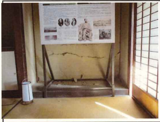
立岩邸 壁修繕
