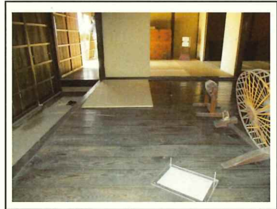
安積開拓入植者住宅(旧坪内家) 建具修繕
