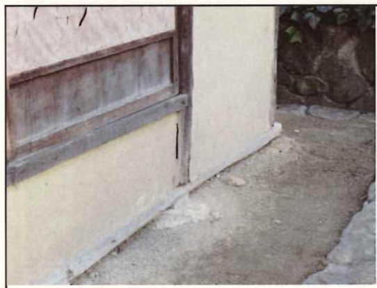
安積開拓入植者住宅(旧小山家) 柱修繕
