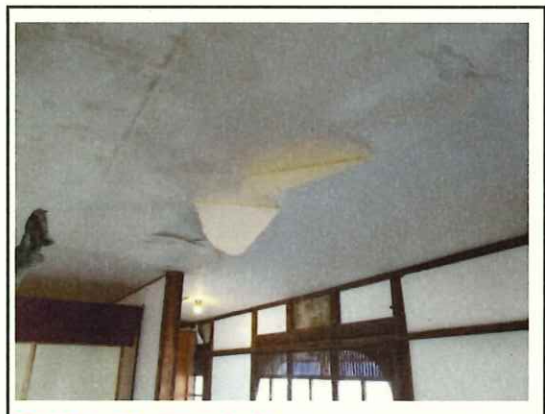
開成館3階 天井修繕
