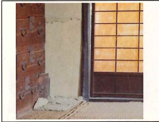
安積開拓入植者住宅(旧小山家) 壁修繕
