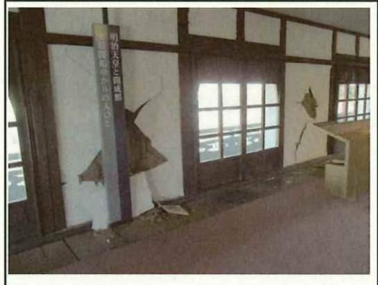
開成館 壁修繕
