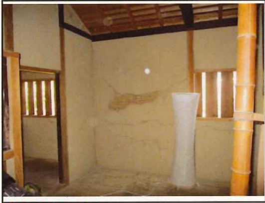
立岩邸 壁修繕
