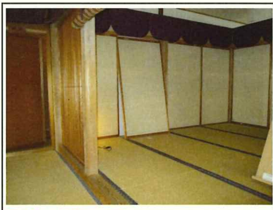
開成館 床等木工事
