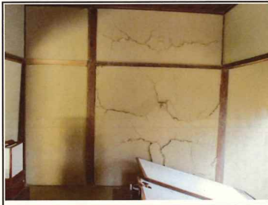
立岩邸 壁修繕
