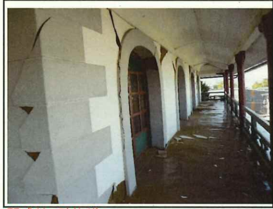
開成館 壁修繕
