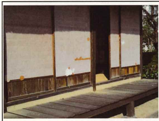
安積開拓入植者住宅(旧小山家) 建具修繕
