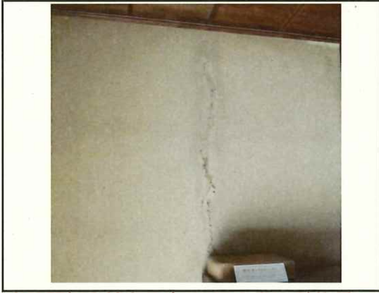
安積開拓入植者住宅(旧坪内家) 壁修繕
