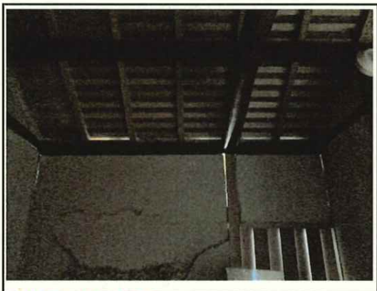
立岩邸 柱等修繕
