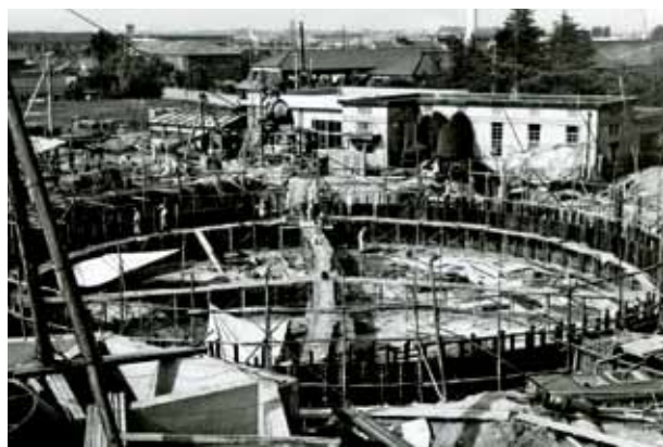
浄水池築造工事
