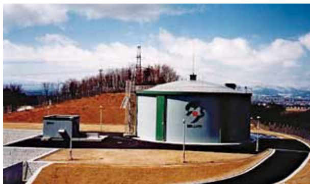
高倉配水池（平成10年完成）
