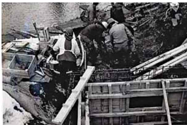
取水設備築造工事
