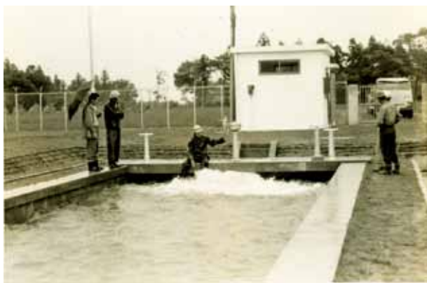
矢地内沈砂池（矢地内取水場：大槻町）
