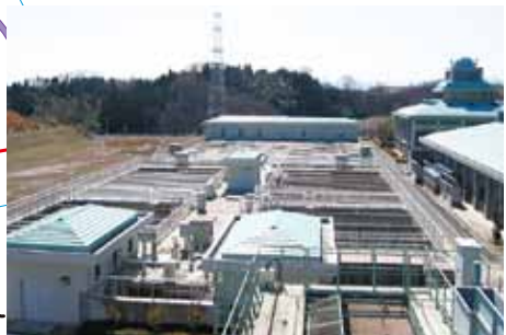
荒井浄水場 施設能力 42,000 m 3 /日
