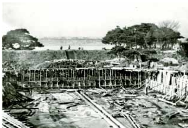
緩速ろ過池築造工事
