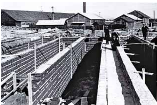
配水池築造、流水壁レンガ積立工事
