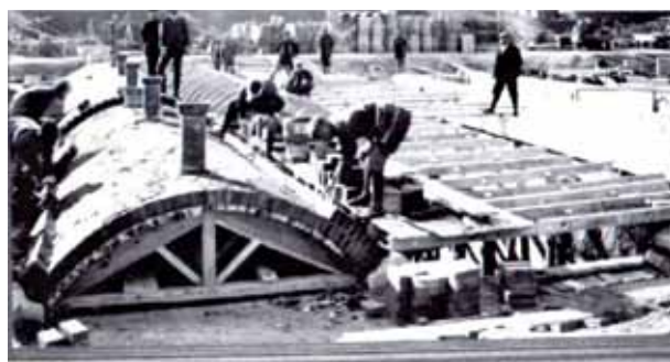
配水池築造、アーチ積工事
