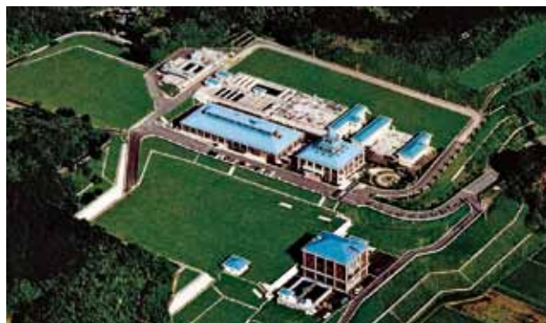
荒井浄水場（平成9年度完成）
