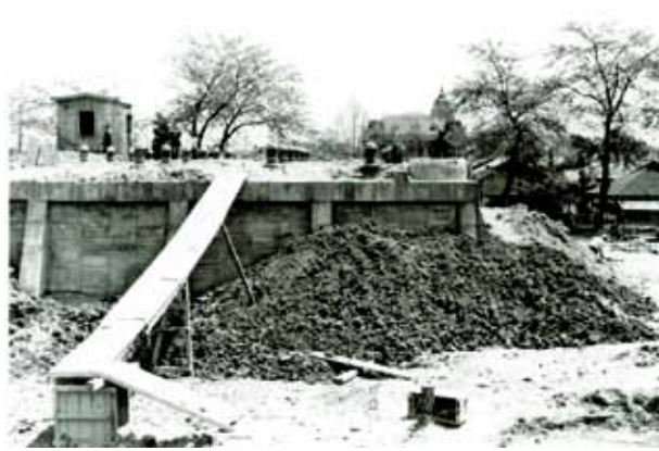
麓山の低区配水池築造工事
