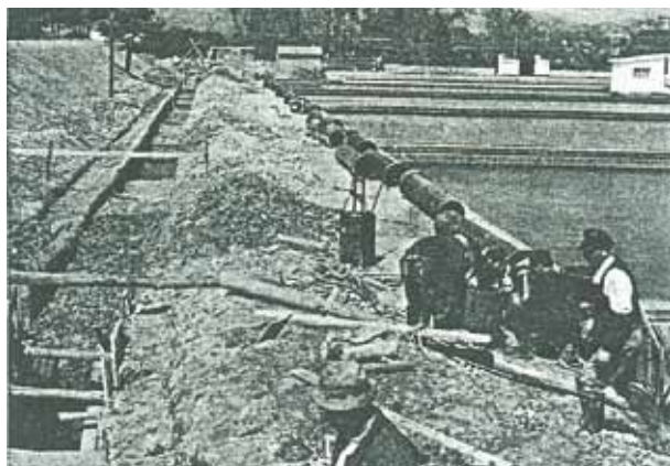
豊田浄水場内導水管布設工事
