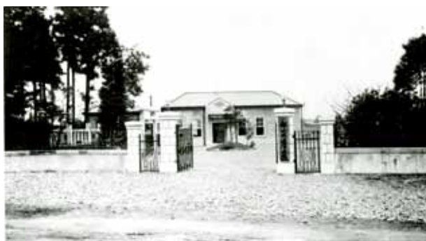
大正時代の豊田浄水場
