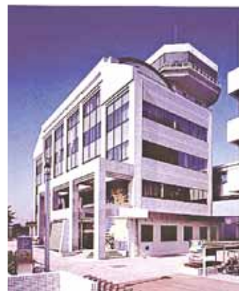
水道局新庁舎
