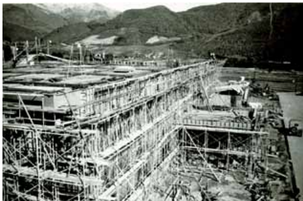
堀口浄水場本館築造工事
