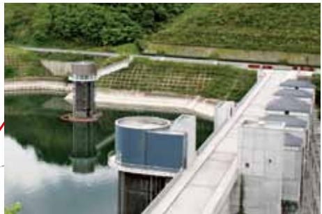
三春ダム取水塔 取水量 42,595 m 3 /日
