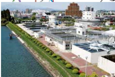
豊田浄水場 施設能力 57,200 m 3 /日
