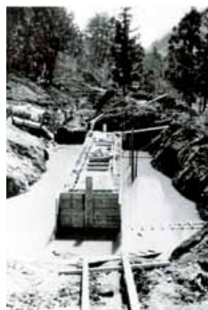
沈砂池築造工事
