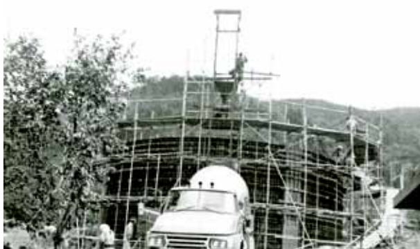
配水池築造工事
