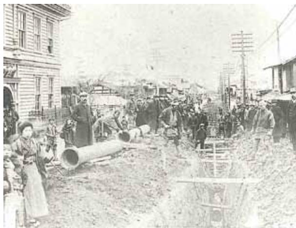
配水管布設工事 （現在のフロンティア通り）
