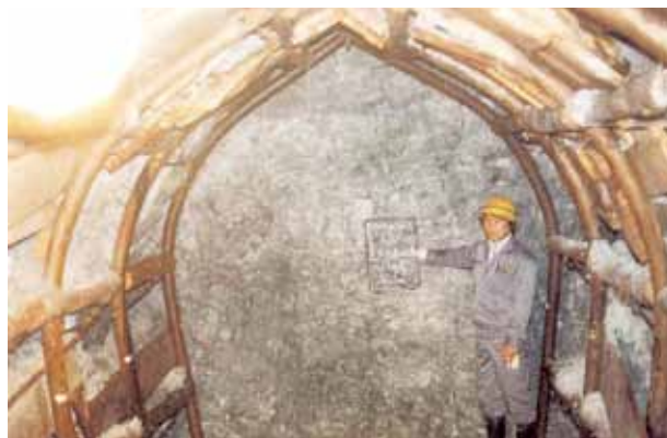
導水ずい道掘削状況
