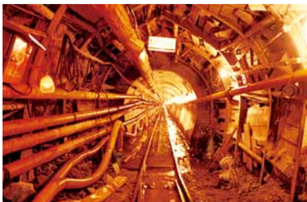
導水ずい道建設工事
