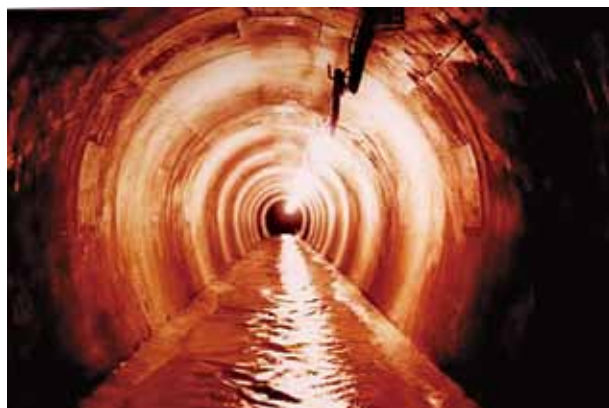
導水ずい道内部（通水前）
