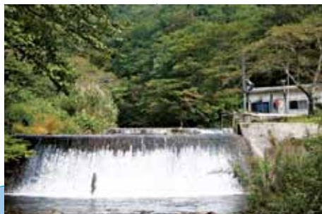
深沢川取水場 取水量 3,000m 3 /日
