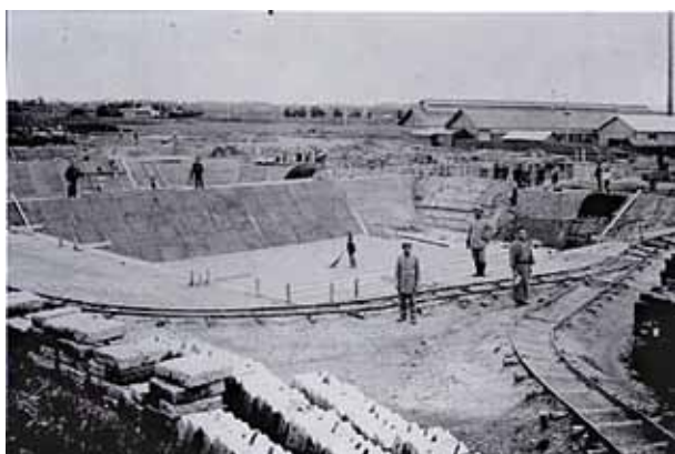
緩速ろ過池築造、側壁アスファルト塗抹工事
