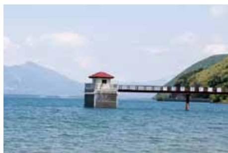
浜路取水塔 取水量 76,896m 3 /日
