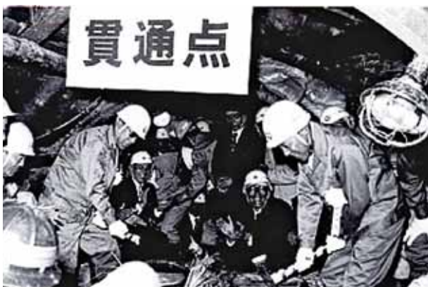
導水ずい道貫通地点
