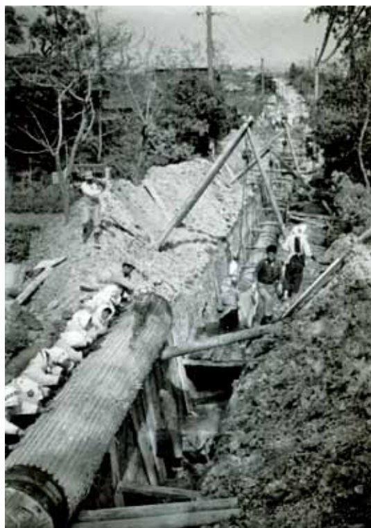
導水管布設工事
