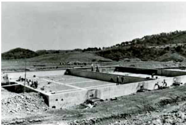
緩速ろ過池築造工事
