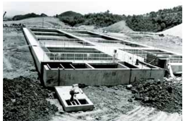
薬品沈でん池築造工事
