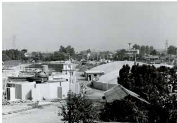
完成した急速沈でん池、急速ろ過池及び浄水池
