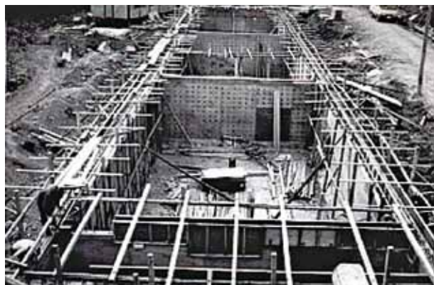
沈でん池築造工事
