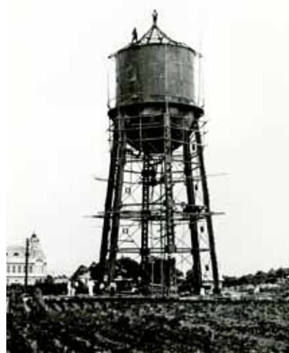
麓山の高架水槽（昭和46年3月撤去）
