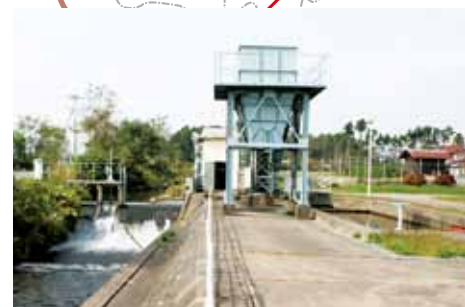
矢地内取水場 取水量 36,288m 3 /日
