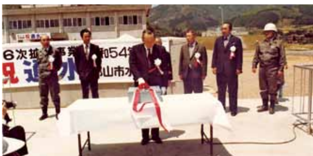
ずい道通水式（昭和54年5月22日）
