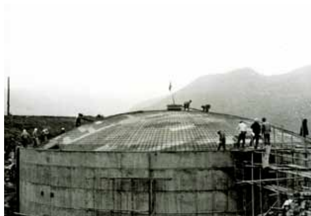
本宮館配水池築造工事
