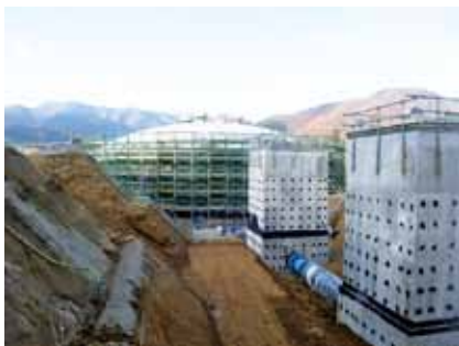
堀口浄水場浄水池建造工事
