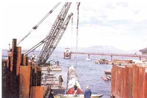
導水管水中布設工事
