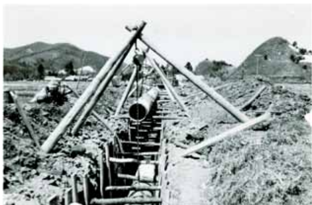
導水管布設工事
