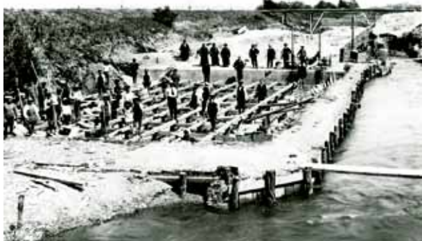
逢瀬川集水埋渠築造工事（現逢瀬川第1取水場）
