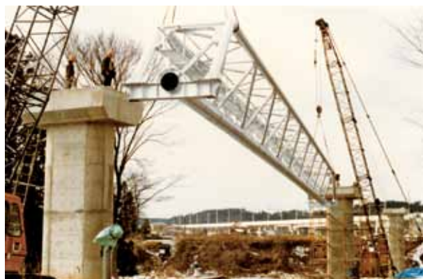
御代田水管橋上部工事
