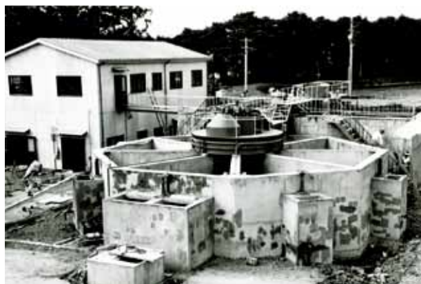
急速沈でん池及び急速ろ過池築造工事
