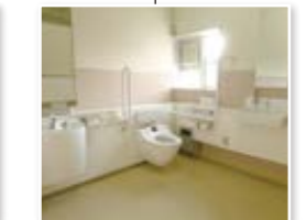
Disabled access toilet バリアフリートイレ
