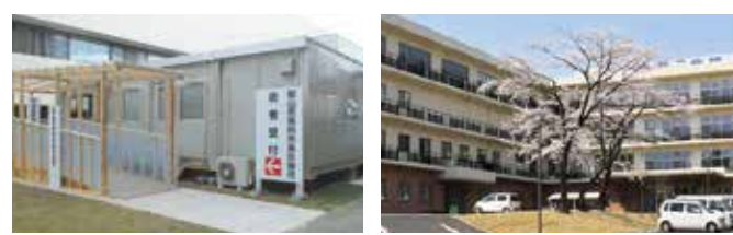
向河原町発熱外来診療所 (星総合病院敷地内) 八山田発熱外来診療所 (南東北第二病院内)
