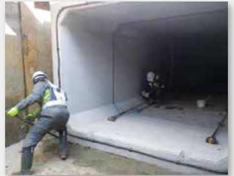
『整備中の133号雨水幹線(中央工業団地)』
