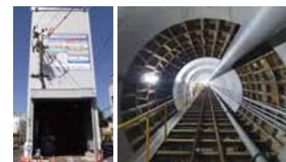
雨水貯留管(図景地区)の整備
