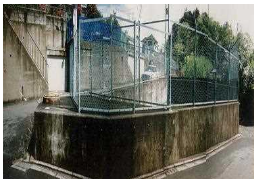
従前の防災調整池
