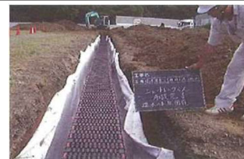
浸透トレンチ
