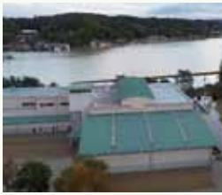
浸水したりサイクルプラザ
