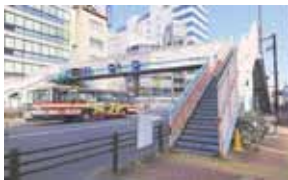
さくら陸橋（郡山駅前）
