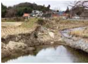
川の水にえぐられた水田 (田村町谷田川地内)
