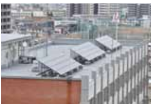
市役所に設置されている太陽光パネル
