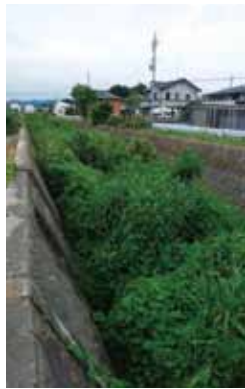
樹木が繁茂する照内川
