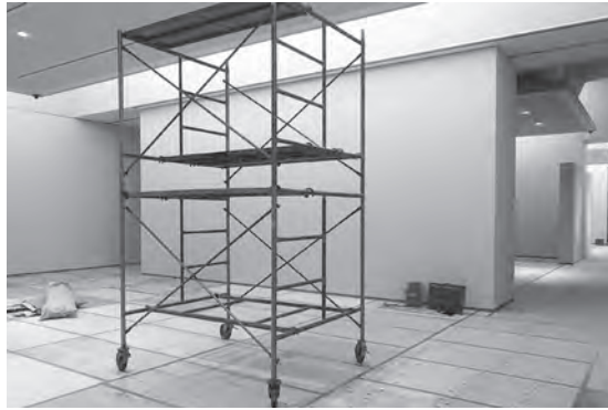
・床養生（平成30年1月16日撮影）
