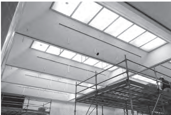
・ライティングダクト設置 (1月16日、22日撮影)
