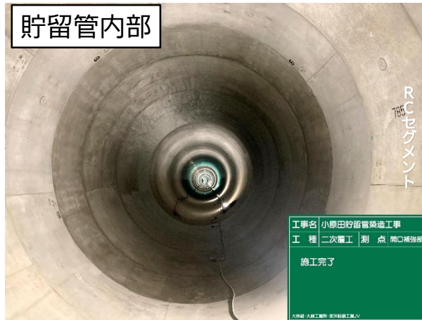
開口補強部のモルタル吹付完了状況
