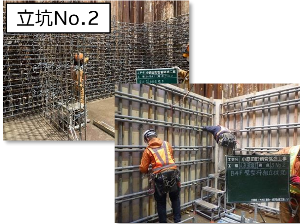
特殊人孔築造(配筋・型枠)状況
