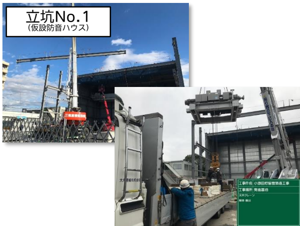
仮設防音ハウス解体・撤去状況
