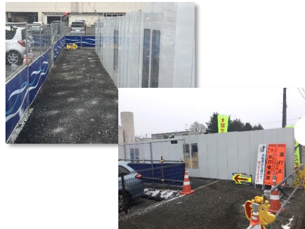
仮囲い設置及び歩道確保状況
