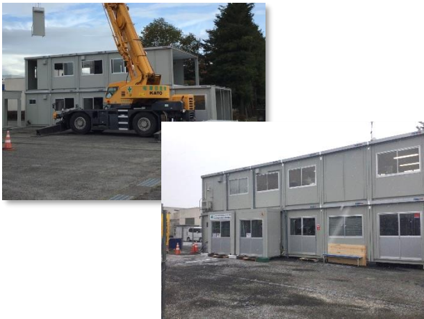
現場事務所設置状況
