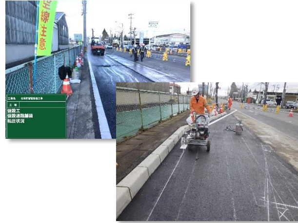
仮設道路設置(道路切り回し)状況
