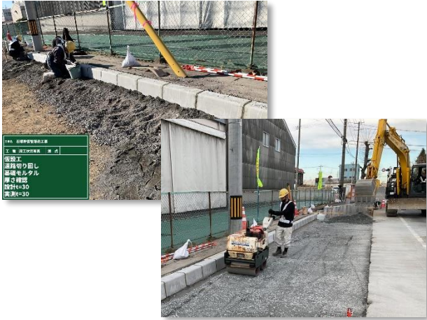
仮設道路設置(道路切り回し)状況
