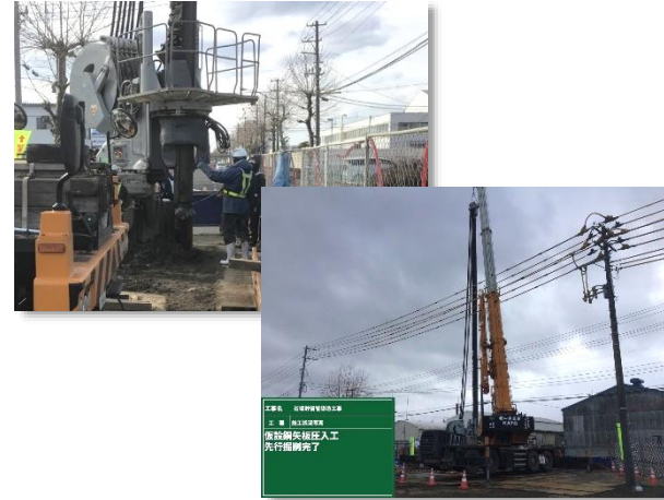
仮設土留設置(先行掘削)状況
