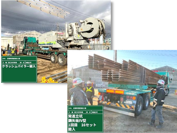
仮設土留設置機器及び鋼矢板搬入状況
