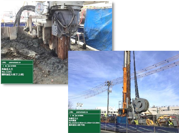
仮設土留(鋼矢板圧入)設置状況
