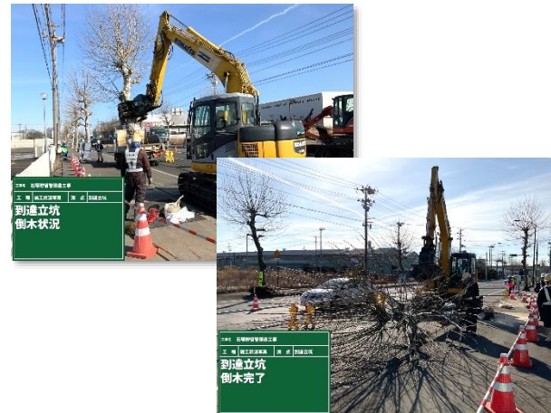
到達立坑に係る支障物撤去状況
