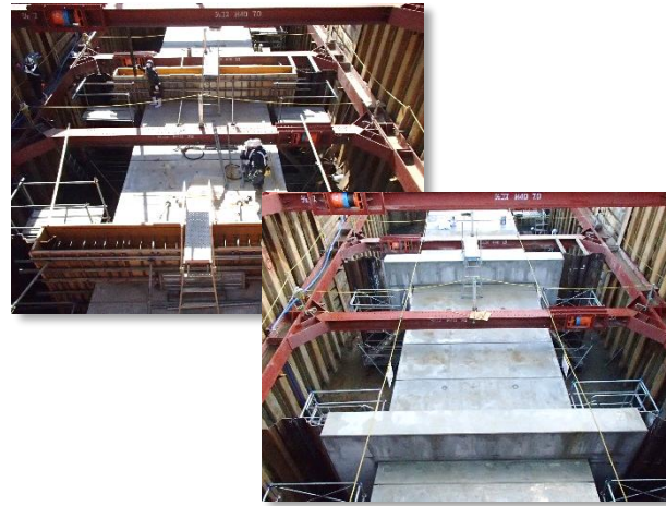
樋門本体遮水壁設置状況
