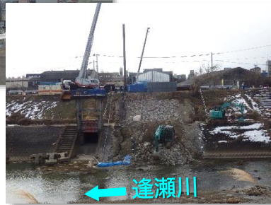
仮設土留施工状況
