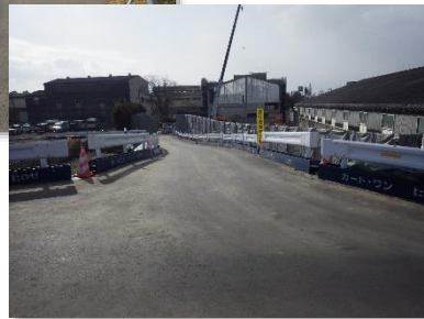
仮設道路設置状況
