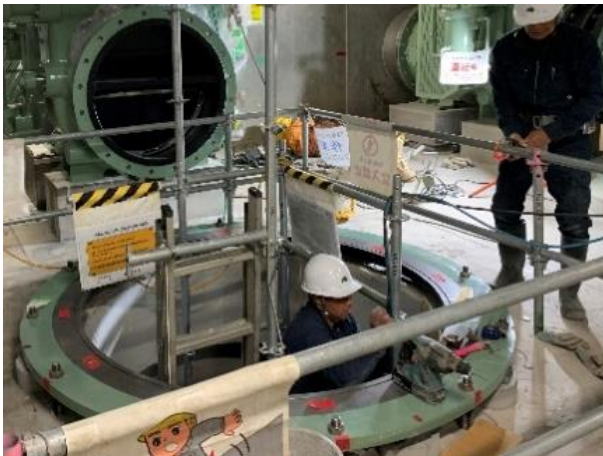
雨水ポンプ用ポンプベース設置状況
