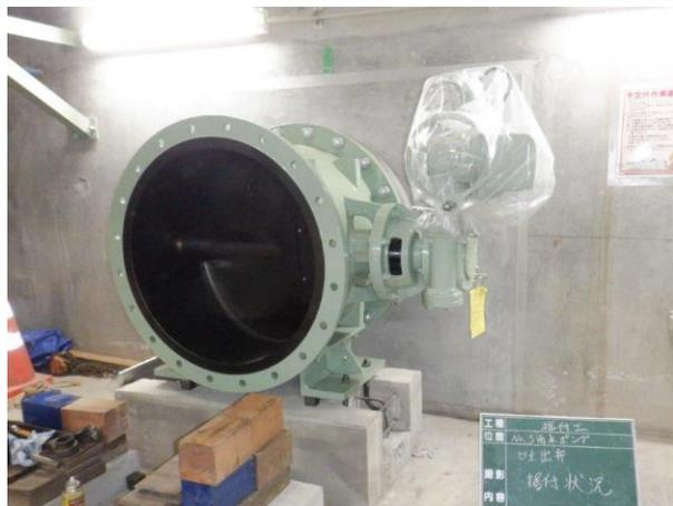
No.3雨水ポンプ用吐出弁設置状況
