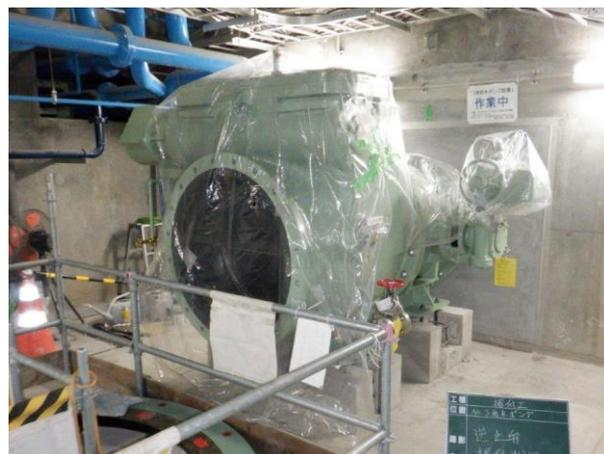
No.3雨水ポンプ用逆流防止弁設置状況
