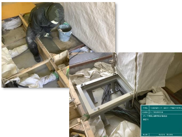
ピット工事(コンクリート打設・架台設置)状況
