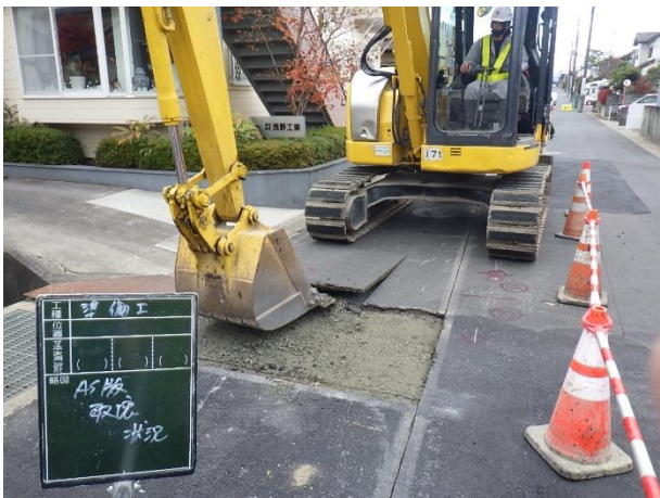
舗装取壊し状況
