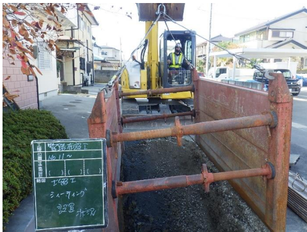
建込簡易土留設置状況
