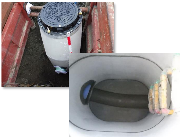
汚水管用特1号マンホール設置状況
