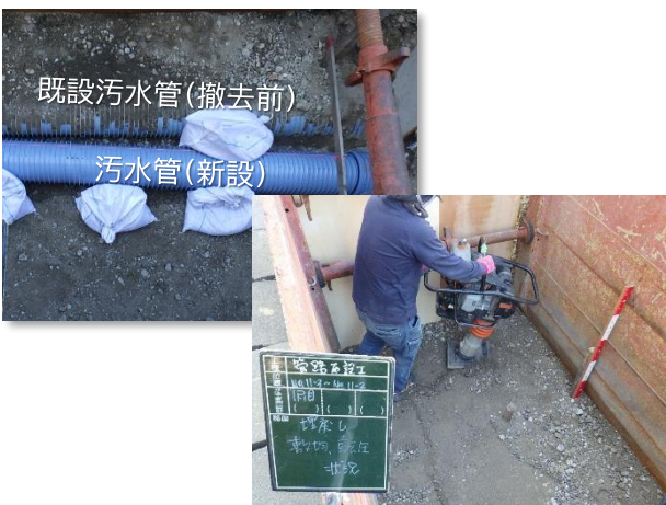
汚水管布設・埋戻し(転圧)状況
