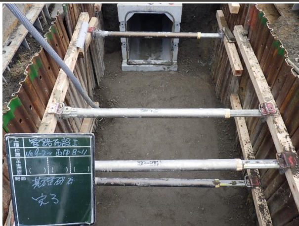
仮設土留・基礎工(砕石)状況
