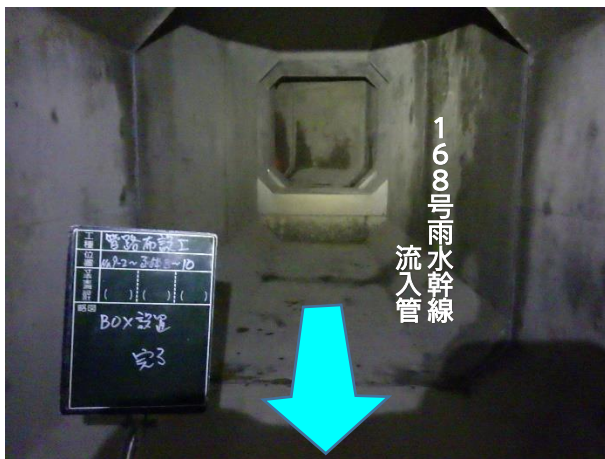
ボックスカルバート布設(内部)状況
