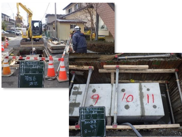
ボックスカルバート布設状況
