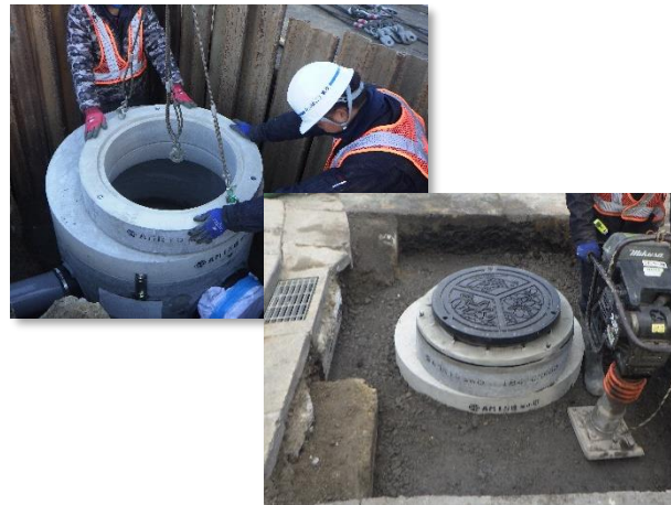
人孔設置状況
