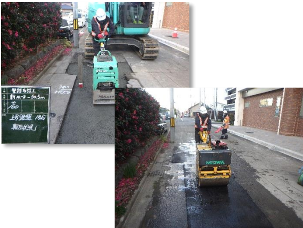
舗装仮復旧状況
