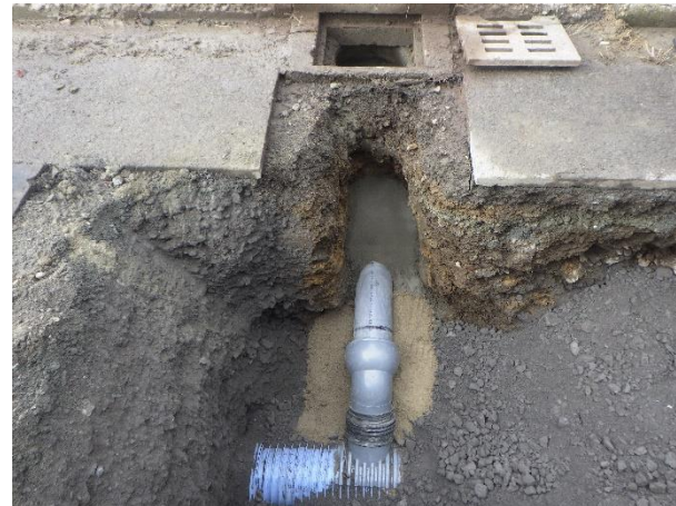
既設街渠柵接続替え状況
