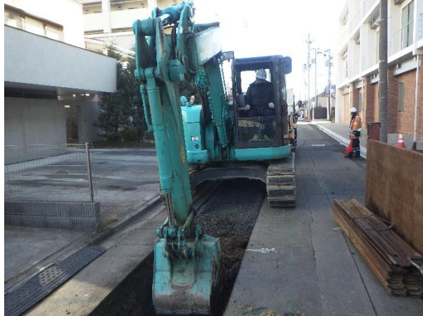
舗装切断・掘削状況
