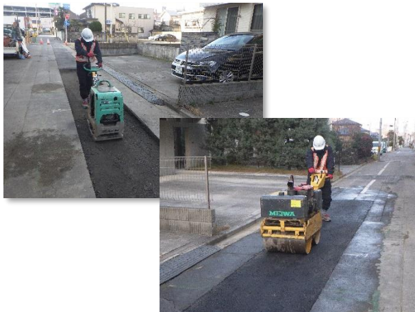
舗装仮復旧状況
