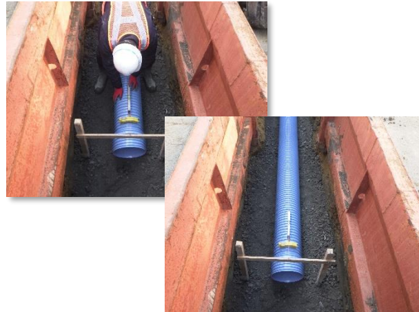
建込簡易土留・合流管布設状況
