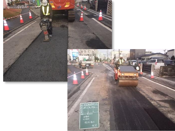
舗装仮復旧状況
