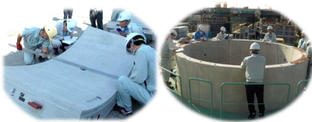
貯留管の部分となるセグメントを工場で作成し、仮組を行います。
