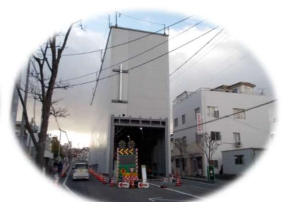
工事により騒音を遮蔽するため、仮設の防音ハウスを組み立てます。
