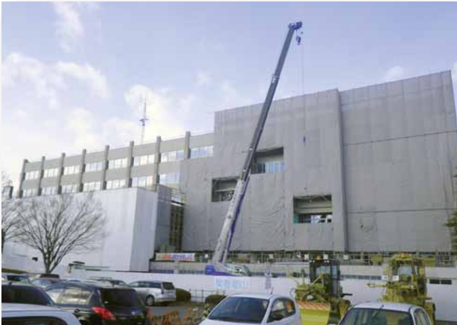
本庁舎改修工事
