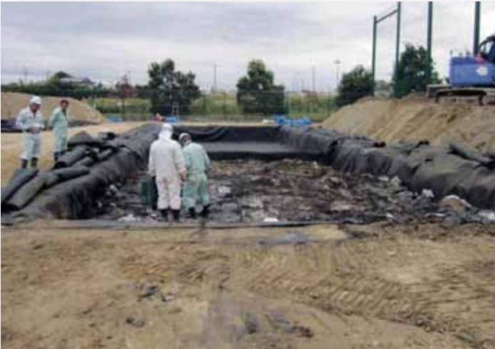
スポーツ広場表土除去
