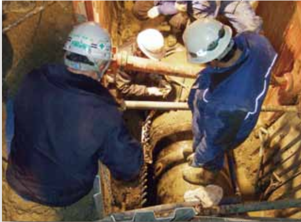
豊田浄水場内配管修繕
