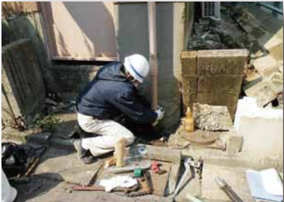
ガス漏れ復旧工事の様子
