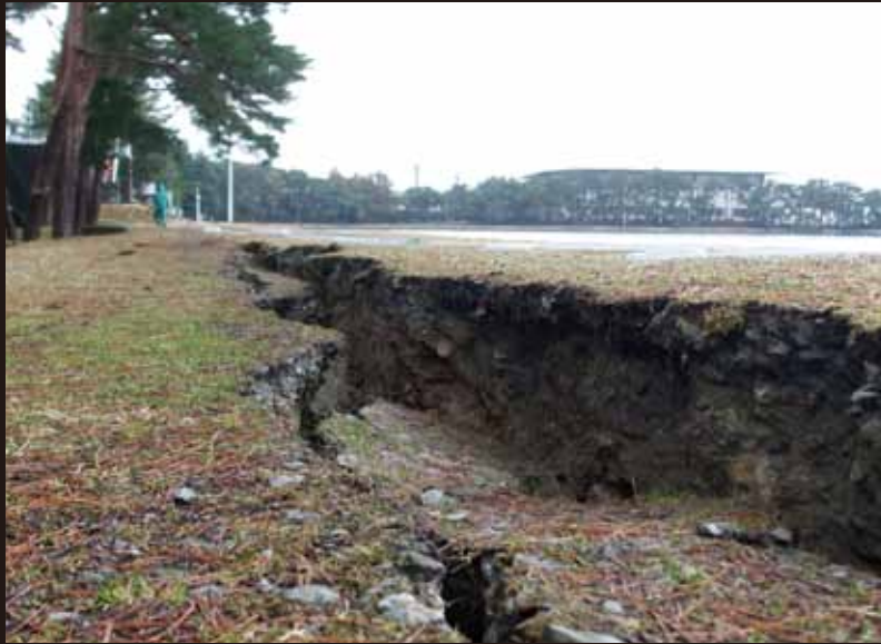
地割れも発生
