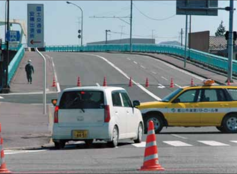
橋崩落の恐れがあり、通行止めに
