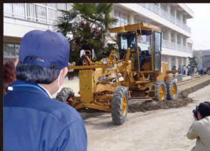
小学校校庭表土除去
