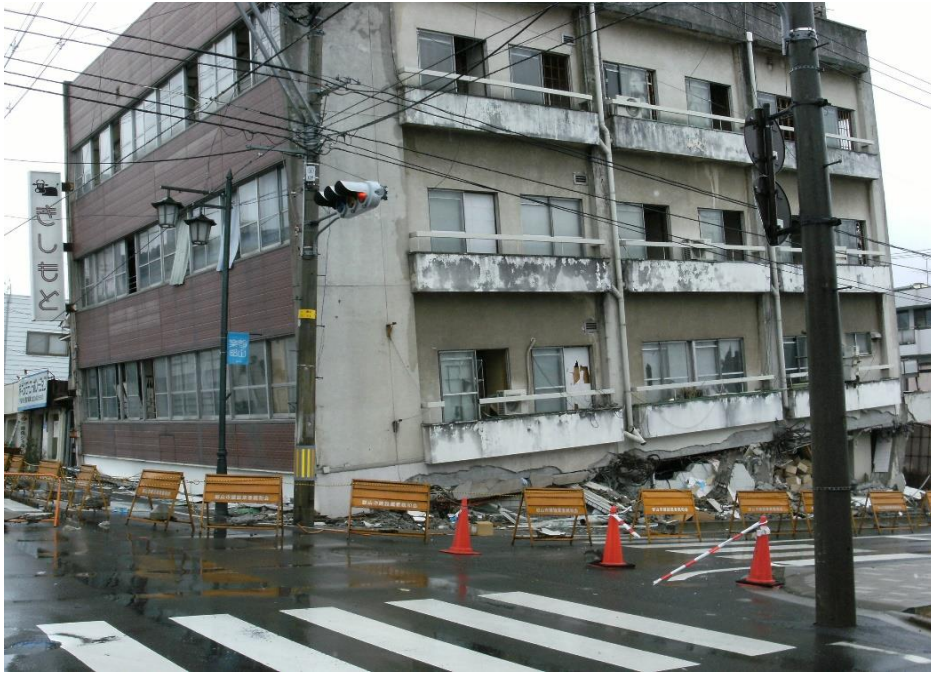
東日本大震災により1階部分が潰れてしまった市内のビル
