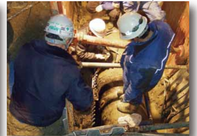
豊田浄水場内配管修繕
