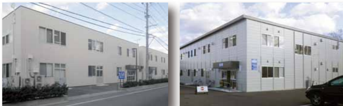
写真左／仮庁舎北棟 写真右／仮庁舎南棟
