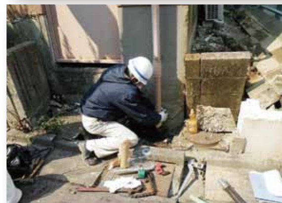
ガス漏れ復旧工事の様子
