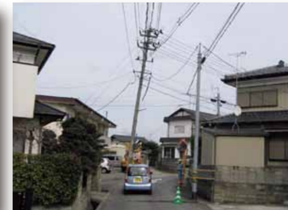
支線抜けによる電柱傾斜
