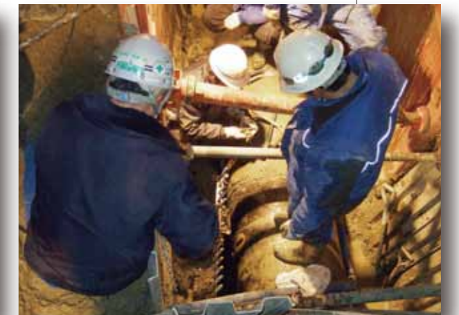
豊田浄水場内配管修繕
