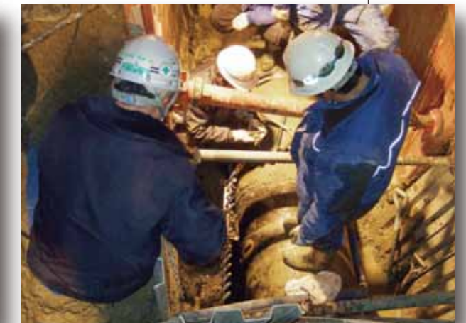
豊田浄水場内配管修繕
