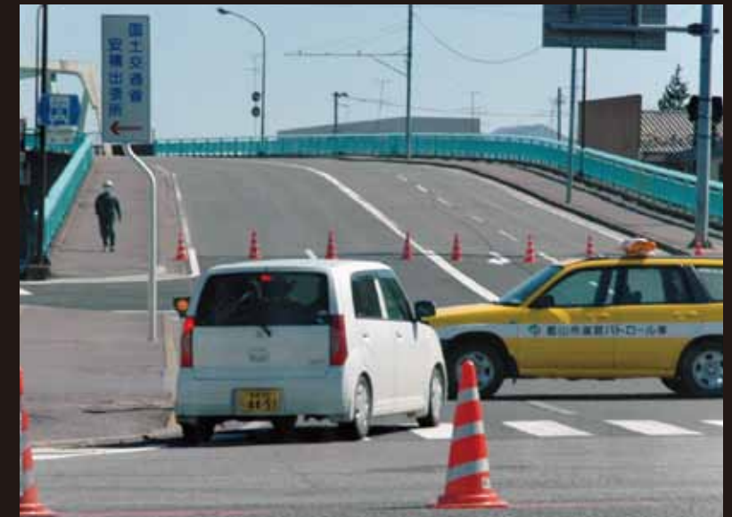
橋崩落の恐れがあり、通行止めに
