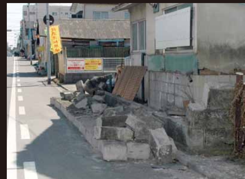
塀が倒れる被害も多数発生 倒れた塀で通行できない道路もあった
