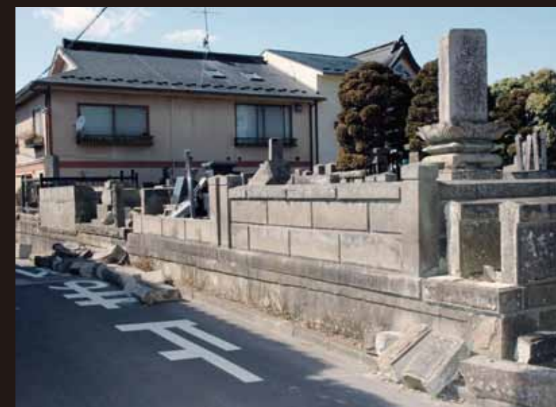
地震で倒れてしまった墓石も多く見受けられた
