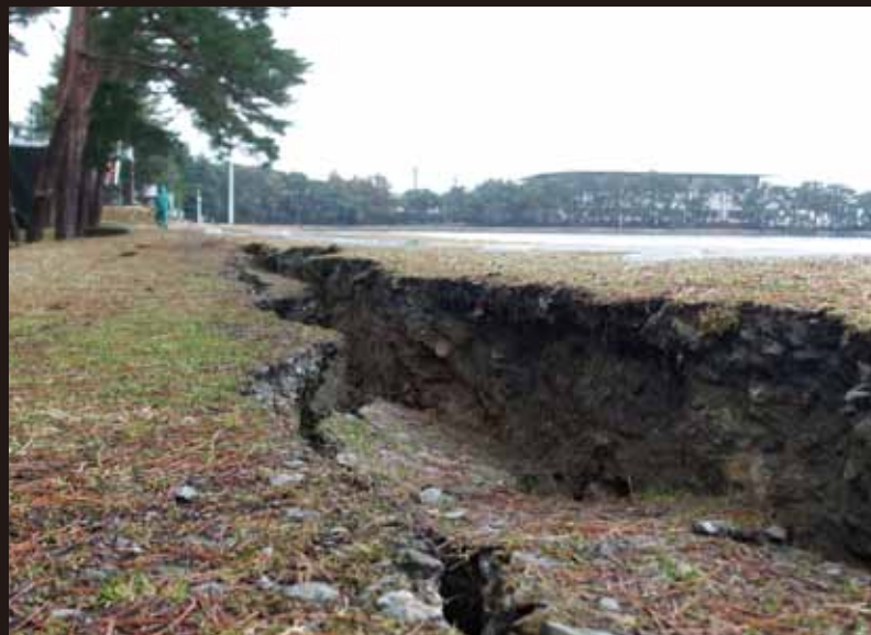
地割れも発生
