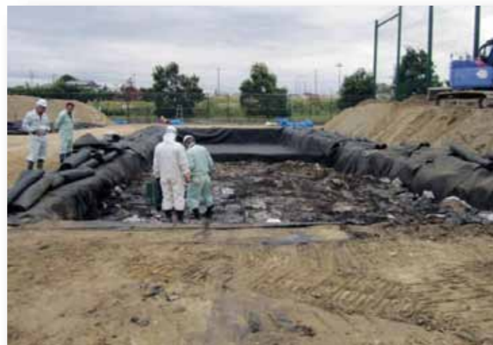
スポーツ広場表土除去
