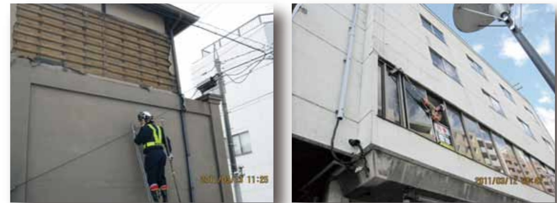
被災建物調査
