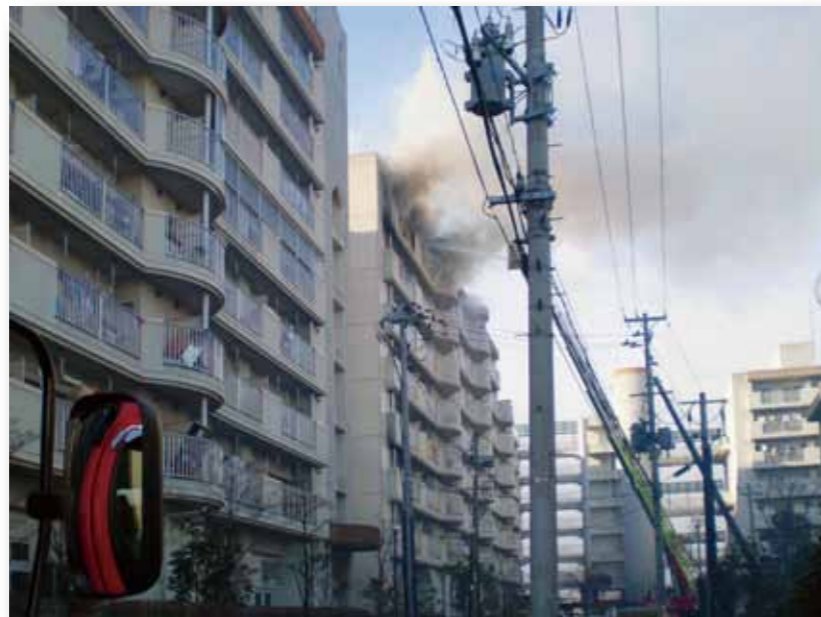
市営住宅火災の発生
