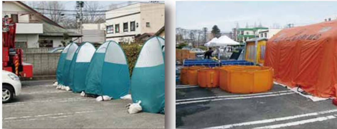
避難者の脱衣と着替えを行うため設営したエアートントと、除染した汚水を貯留するため設営した簡易水槽等
