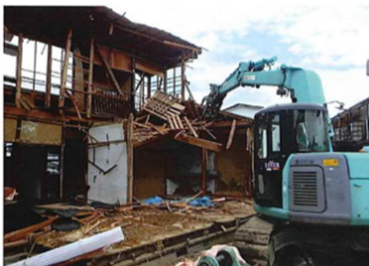
【被災家屋の公費解体の様子】
