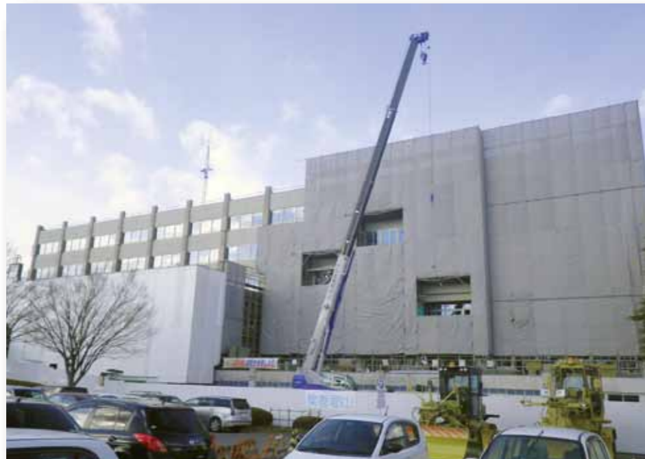
本庁舎改修工事
