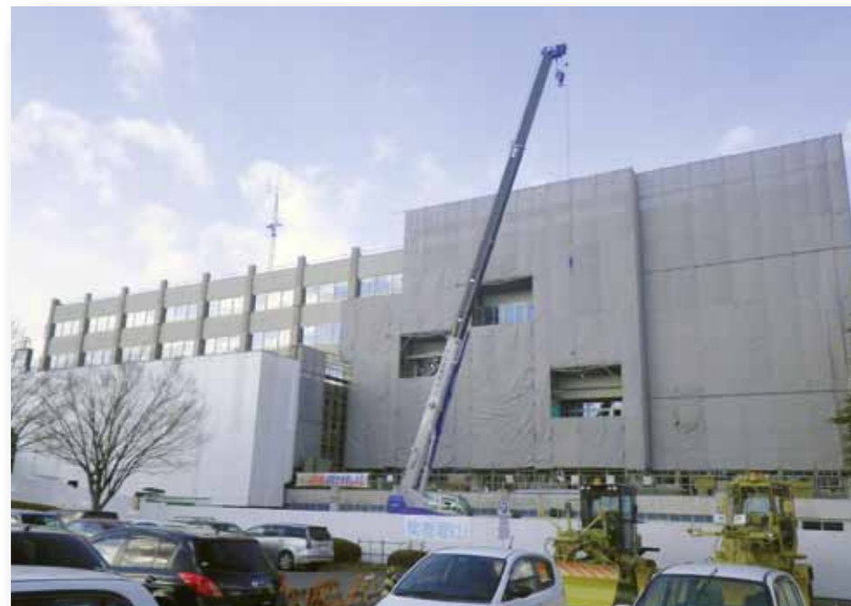
本庁舎改修工事
