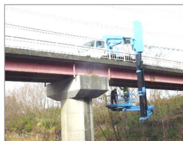
橋りょう点検の状況
