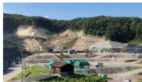
第4期埋立地造成工事
