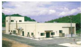
第一污水处理施設
