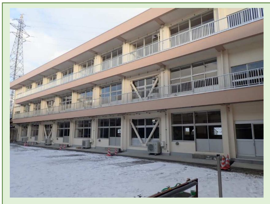
～ 永盛小学校 長寿命化改修 ～
