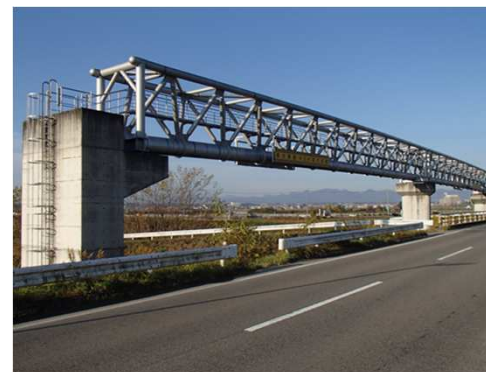
【大善寺水管橋（トラス補剛形式）】
