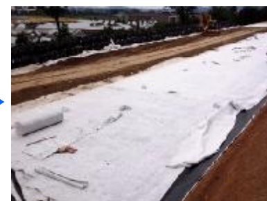
③防水シート・保護マット設置
