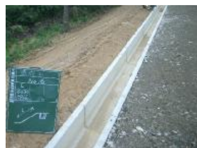
⑤排水溝の設置
