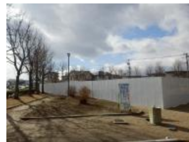
仮囲いの設置
