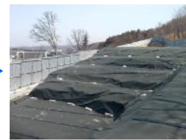
⑦遮水シートで覆い完了
