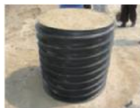
容器の隙間に土を充填
