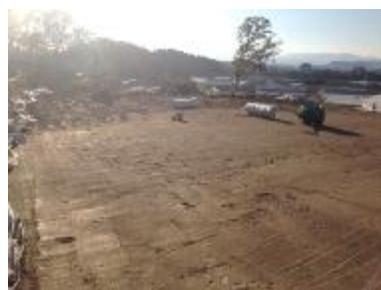
④土による保護層の設置
