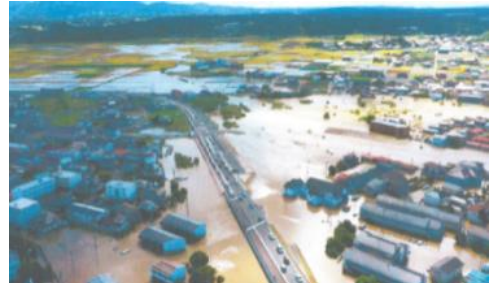
令和元年東日本台風による被害状況
