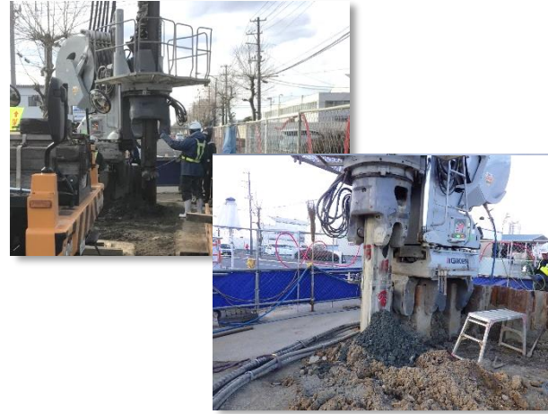
仮設土留(鋼矢板圧入)設置状況
