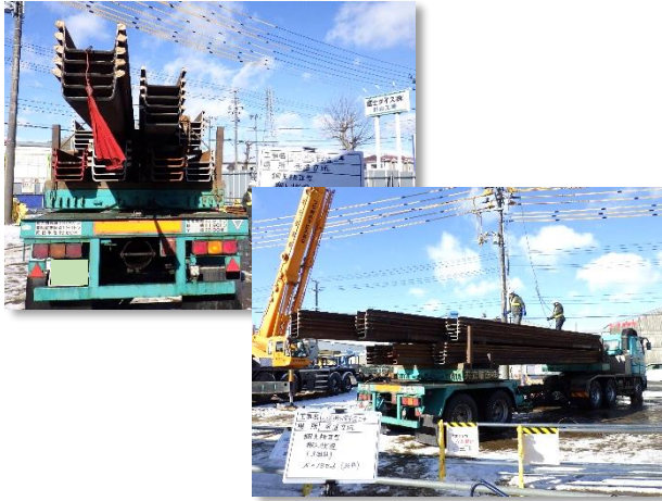
鋼矢板搬入状況
