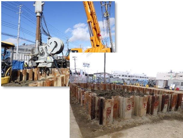
仮設土留(鋼矢板圧入完了)設置状況
