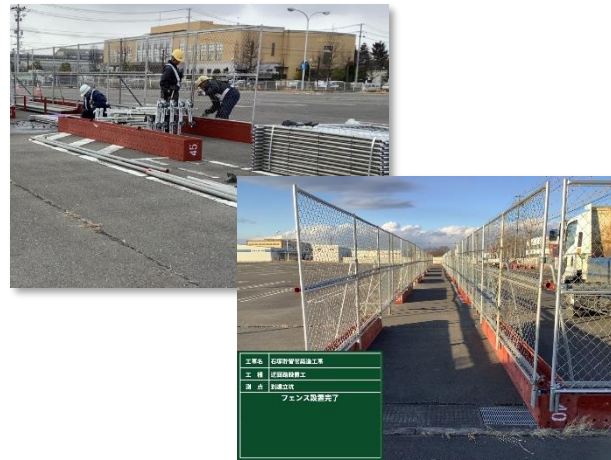
歩行者用迂回路に係るフェンス設置状況
