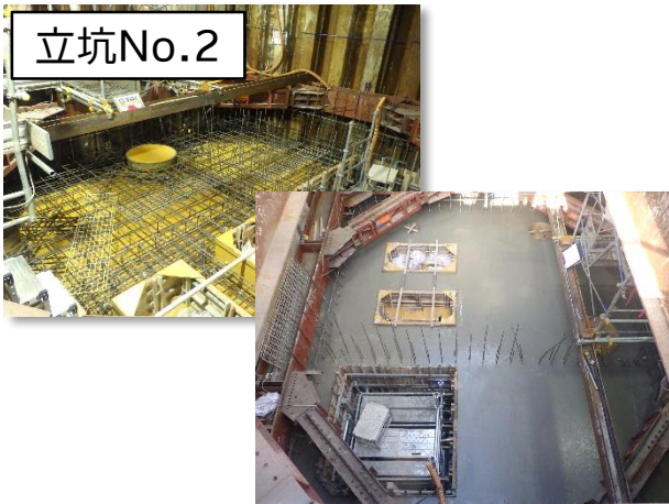
特殊人孔築造(配筋・型枠・コンクリート打設)状況
