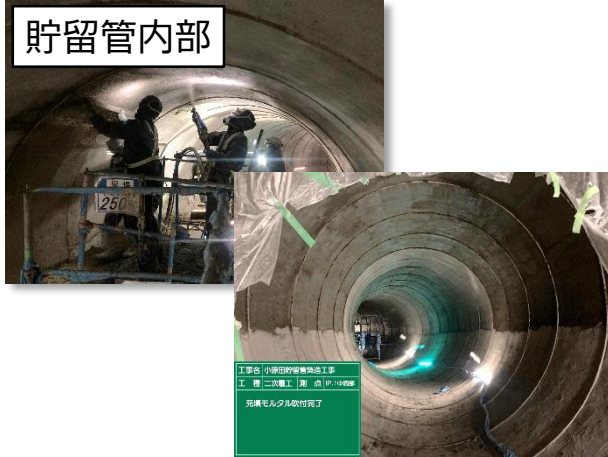
急曲線部のモルタル吹付状況
